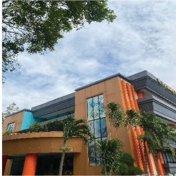
Gambar 2. Selubung Bangunan Gedung PPSDM Migas Cepu (Tampak Samping Kiri) Sumber:Dokumentasi Pribadi
