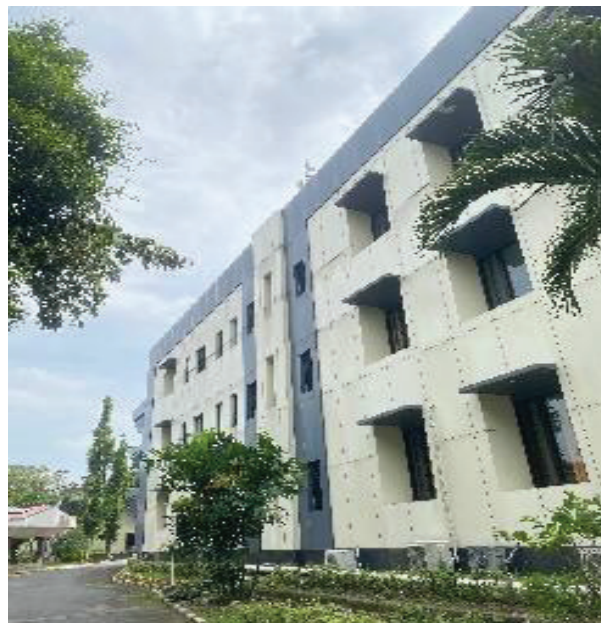
Gambar 5. Selubung Bangunan Gedung PPSDM Migas Cepu (Tampak Belakang) Sumber:Dokumentasi Pribadi
