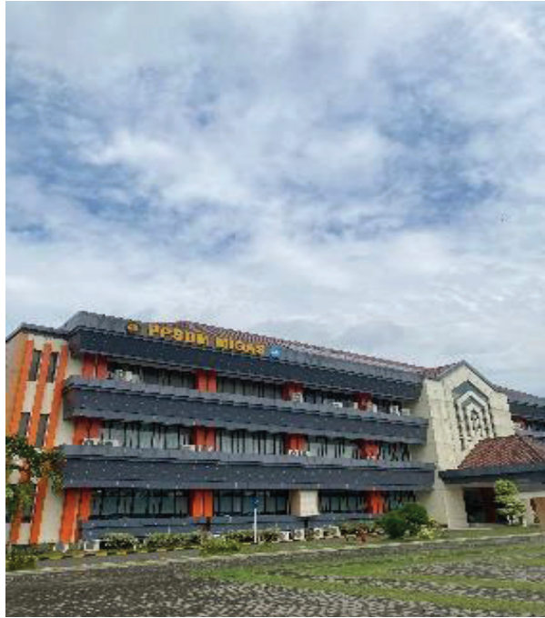
Gambar 4. Selubung Bangunan Gedung PPSDM Migas Cepu (Tampak Depan) Sumber:Dokumentasi Pribadi
