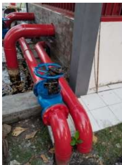
Gambar 3. Sistem Perpipaan Hydran PEM Akamigas, Cepu
