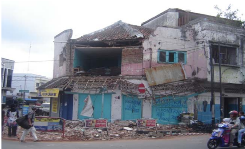
Gambar 4. Kerusakan bangunan di Tasikmalaya akibat Gempa Bumi Jawa Barat 2009. Foto: Rudy Suhendar.
