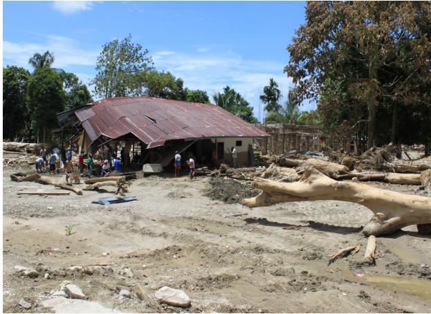
Gambar 4. Kerusakan sebagian perumahan penduduk di Desa Rado akibat terlanda aliran bahan rombakan dari Sungai Rado.
