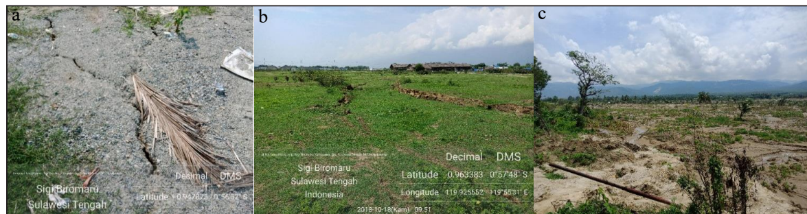
Gambar 1. a) Kerusakan likuefaksi rendah pada Jalan Poros Palolo Kabupaten Sigi; b) Kerusakan Likuefaksi menengah pada salah satu wilayah di Kabupaten Sigi; c) Kerusakan likuefaksi tinggi pada salah satu wilayah di Kabupaten Sigi.
