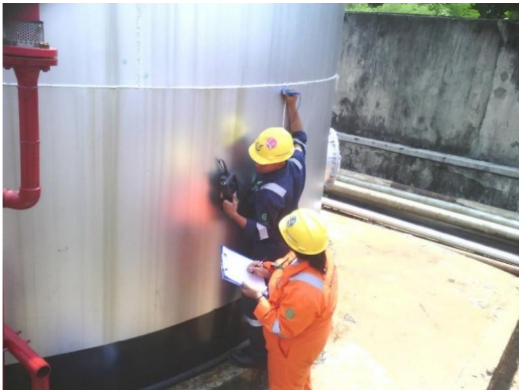
Gambar 5 Pengukuran Ketebalan Aktual Menggunakan UT Thickness Gauge
