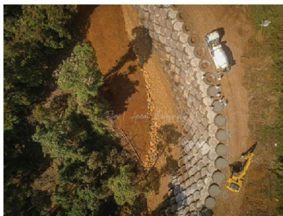
Gambar 6 Struktur dinding penahan tanah dan pekerjaan pelebaran jalan km 8 +200 (tampak atas) (Sumber: Dokumentasi pribadi)
