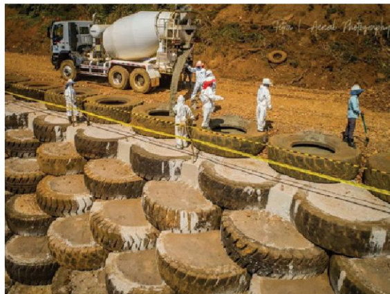
Gambar 5 Struktur dinding penahan tanah dari ban bekas dalam tahap konstruksi pada km 8 +200 (tampak samping) (Sumber: Dokumentasi pribadi)
