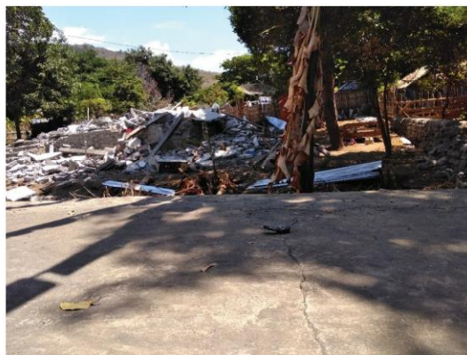
Gambar 3. Retakan tanah akibat kejadian gempa bumi 29 Juli 2018 mengakibatkan robohnya rumah penduduk di Dusun Malempo, Desa Obel-Obel, Kecamatan Sembalun, Kabupaten Lombok Timur (Dokumen Penulis).
