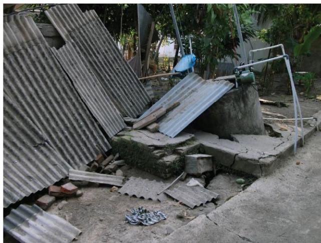
Gambar 10. Proses likuefaksi akibat gempa bumi, 5 Agustus 2018 mengakibatkan kerusakan rumah penduduk dan sumur menjadi miring di Dusun Beraringan, Desa Kayangan, Kecamatan Kayangan, Kabupaten Lombok Utara (Dokumen Penulis).
