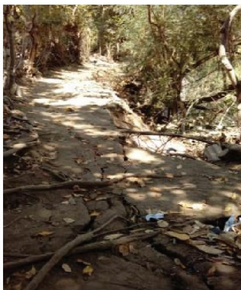
Gambar 4. Retakan tanah akibat kejadian gempa bumi pada 29 Juli 2018 yang mengarah ke lembah dan berpotensi menjadi gerakan tanah di Dusun Ketapang (Dokumen Penulis).
