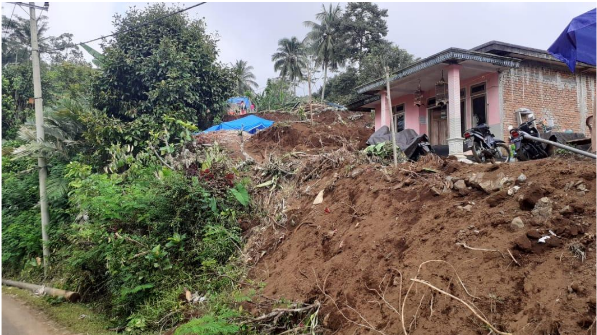
Gambar 2 Kerusakan bangunan karena kualitas bangunan dan kontrol efek topografi (berada di atas punggung), di Dusun Halimo, Desa Kaliuling, Kecamatan Tempursari, Kabupaten Lumajang. Terlihat adanya longsor yang dipicu gempa bumi tanggal 10 April 2021. Foto ke arah timur (Dokumen penulis).
