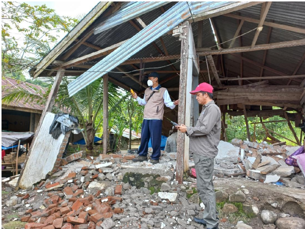
Gambar 9 Rumah penduduk rusak berat akibat gempa bumi tanggal 8 Juni 2022 di Dusun Salunangka, Kelurahan Rengas, Kecamatan Simboro, Kabupaten Mamuju.
