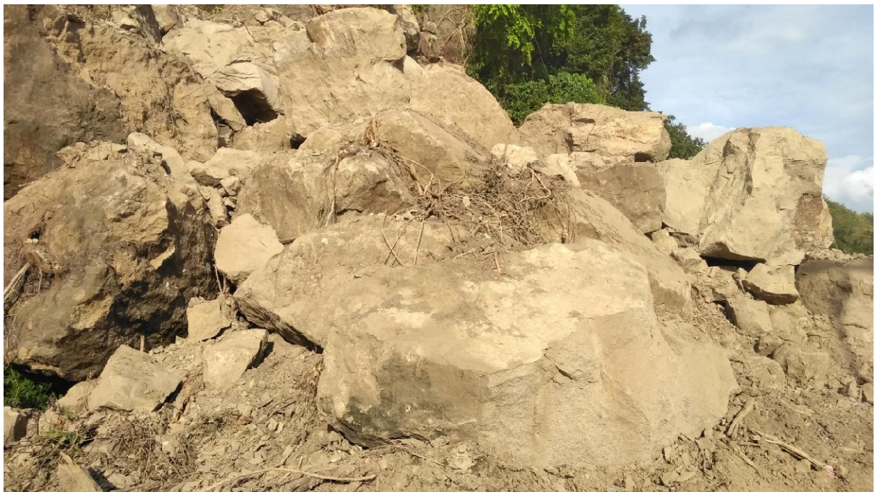
Gambar 6 Material longsor berupa bongkah-bongkah batugamping di Kecamatan Malunda, Kabupaten Majene akibat gempa bumi tanggal 15 Januari 2021 sempat menutup jalan poros Trans Sulawesi.
