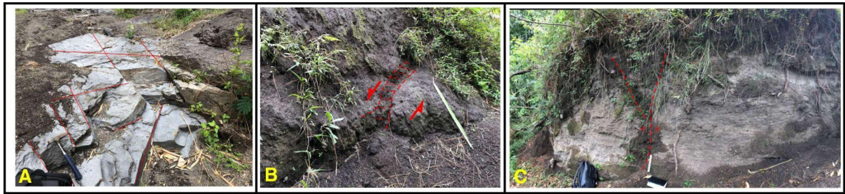
Gambar 6. struktur geologi dan deformasi yang ditemukan dilapangan : A. Kekar berpasangan pada singkapan batuan lava Formasi Gunungapi Agung (Qhva); B. Dinding bidang sesar yang menunjukkan pergerakan mengiri turun pada Batuan perselingan lapili-tuff Formasi Batuan Gunungapi Buyan-Beratan dan Batur Purba (Qpbb); C. Kenampakan stuktur flower structure sesar mendatar kanan pada singkapan batuan lapili-tuff Formasi Batuan Formasi Gunungapi Agung (Qhva).
