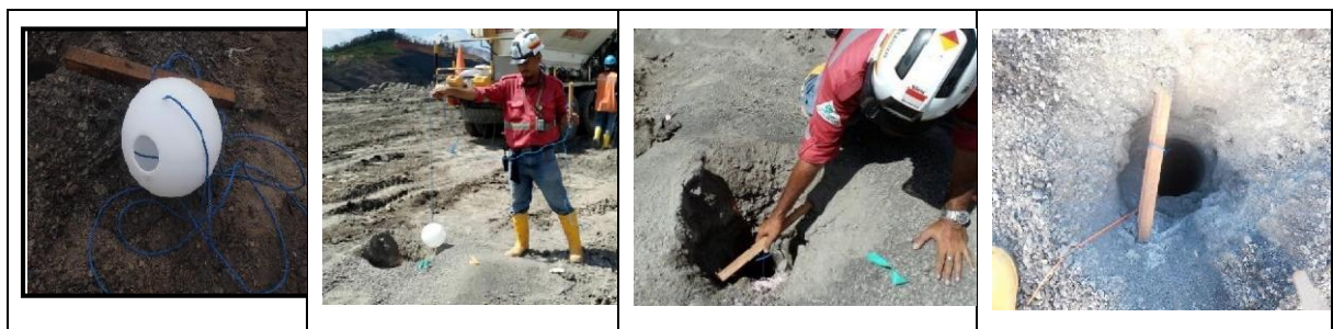
Gambar 3 Pemasangan ball deck di dalam lubang ledak
